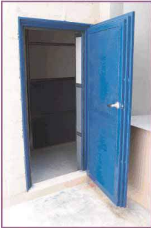
Puerta acústica con núcleo de aislamiento en lana mineral de roca.
