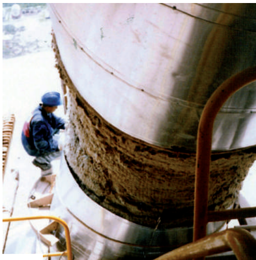
TOLCEMENTOS S.A. Suministro e instalación del aislamiento térmico de los ductos de recirculación de aire caliente de los Homos No.1 y No.2 de secado de Clinker.
